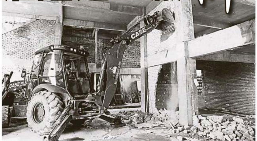
市议会出动神手拆除涉及伪造发展准证的非法建筑工程。
