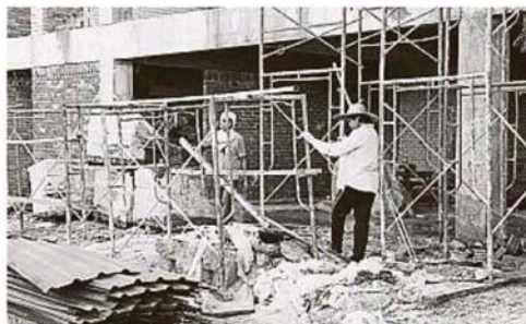
在场的建筑工人在市议会采取行动前整理建筑材料。
