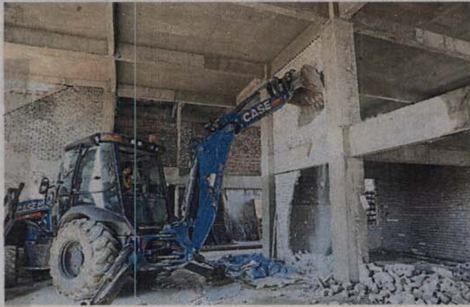
■一间工厂建筑工程因涉及伪造发展准证，非法动工，市议会出动神手拆除。
